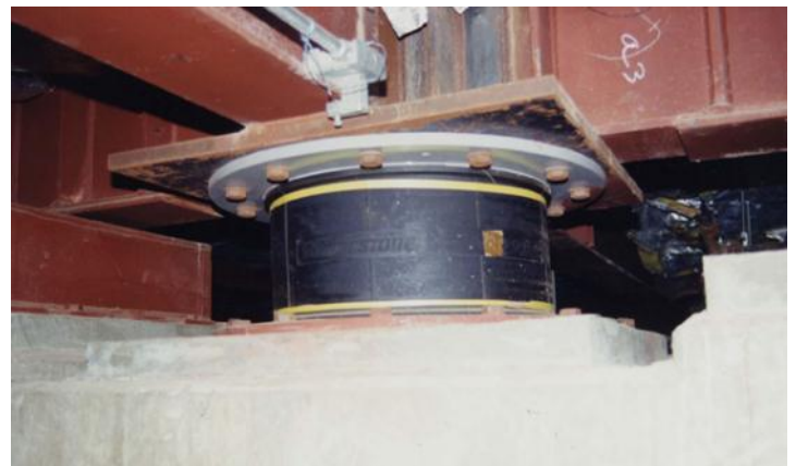
شکل ۳: نمونه ای از بالشتک لاستیکی ( Laminated Rubber Bearing )
